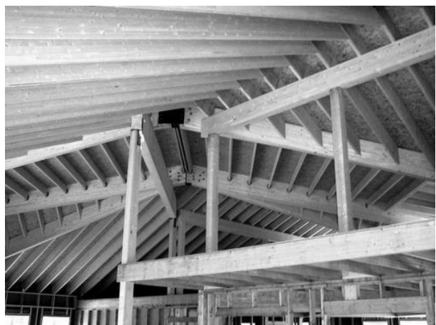
Limtrekonstruksjon, Sør laminering 200X Fotograf: NN
